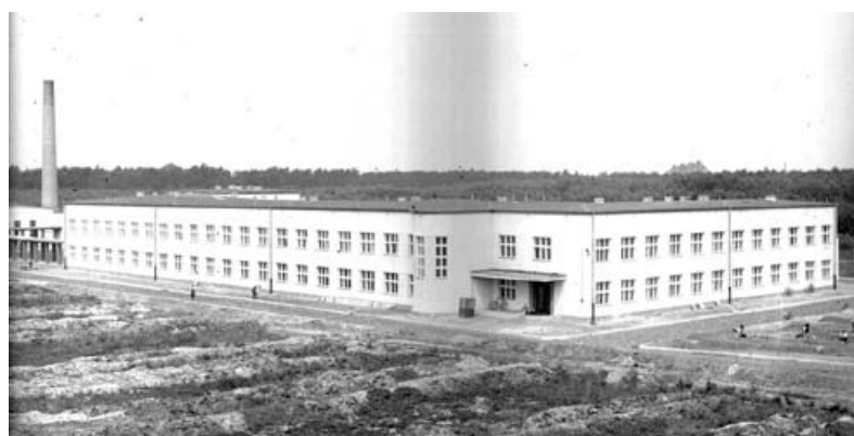
Zakład Głuchych w trakcie kończenia robót budowlanych w 1931 roku.
