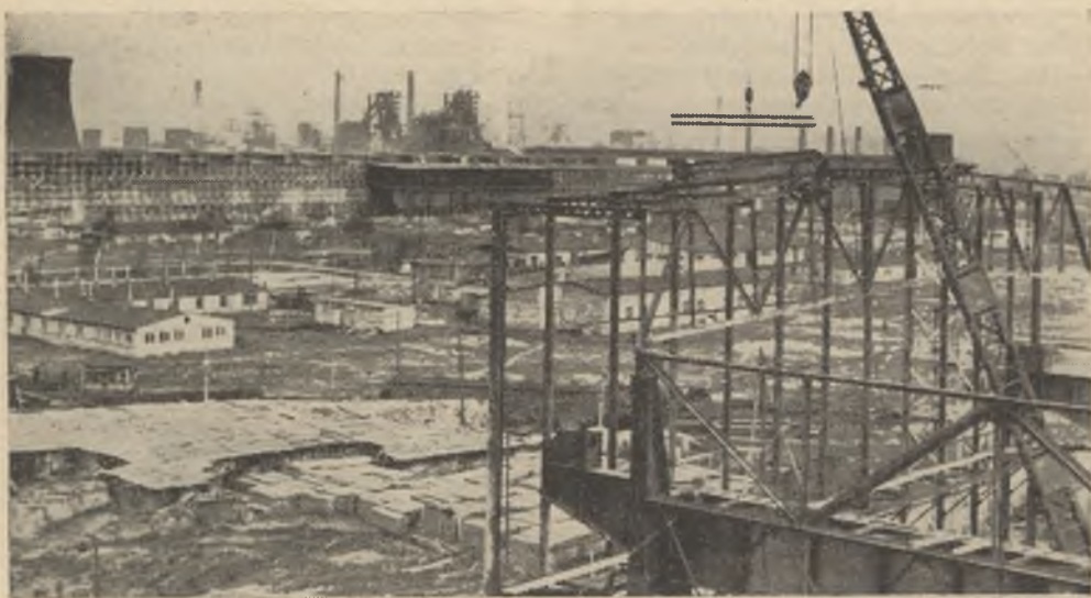
Rozbudowa huty im. Kl. Gottwalda w Witkowicach
