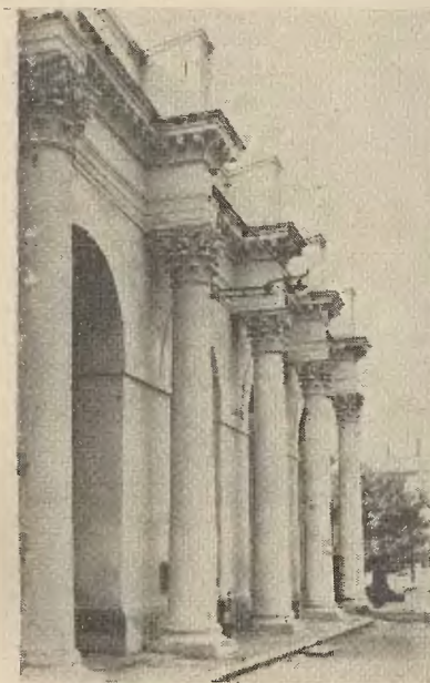
Kolumna u głównego wejścia do Zakładu Zdrojowego
