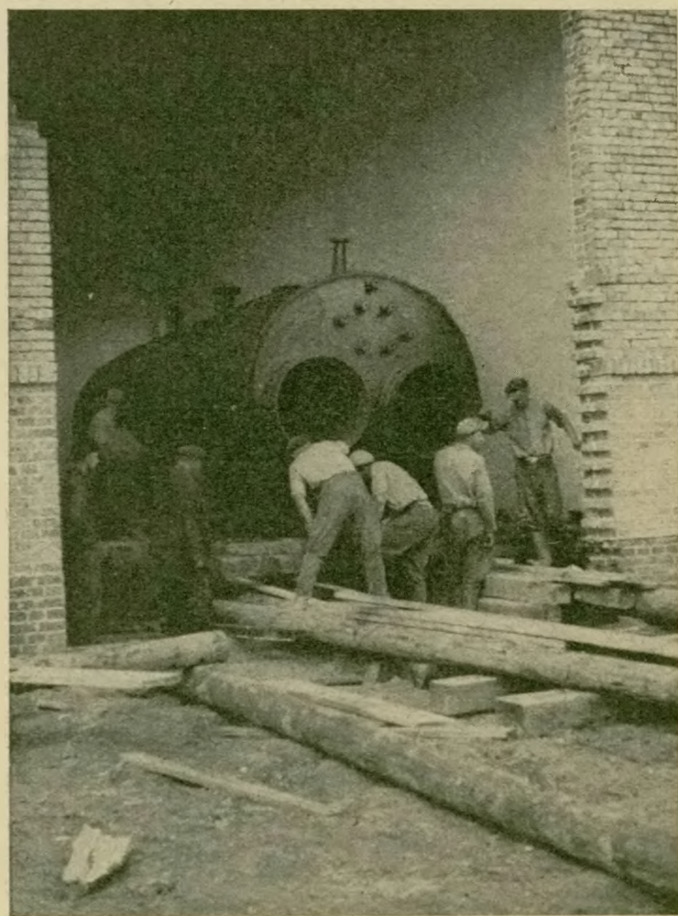
Dwikozy. Fragment budowy. Ustawianie kotła parowego.
