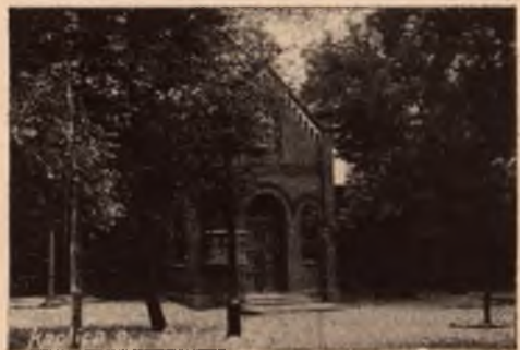
Kaplica św. Rodziny na Kalwarji w Piekarach
