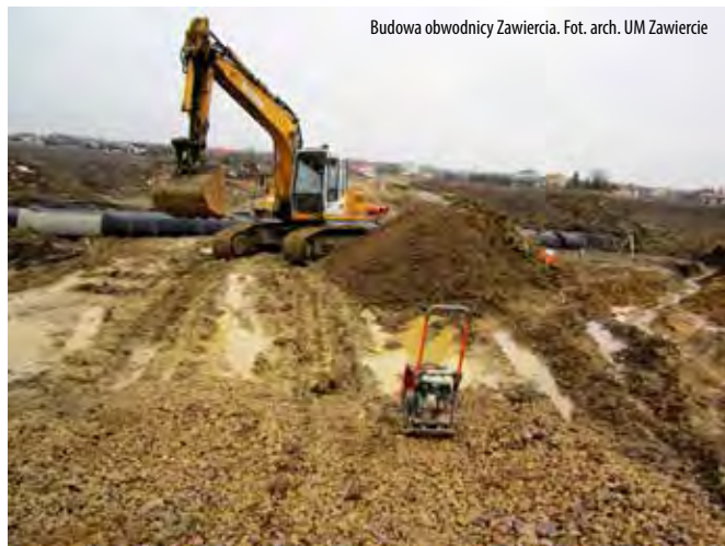
Budowa obwodnicy Zawiercia. Fot. arch. UM Zawiercie
