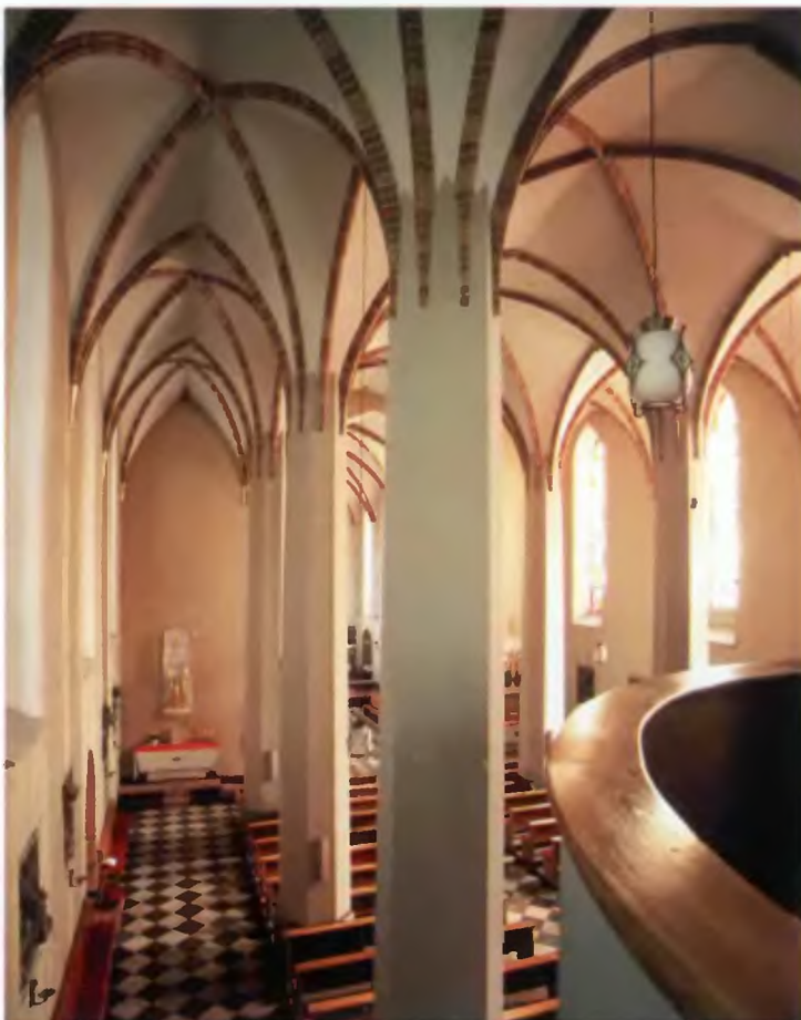
20. Konstrukcja halowa kościoła przejawia się w równej wysokości naw, przy czym przęsło nawy bocznej nie znajduje swego odpowiednika w nawie głównej, różniącej się szerokością przejścia.
