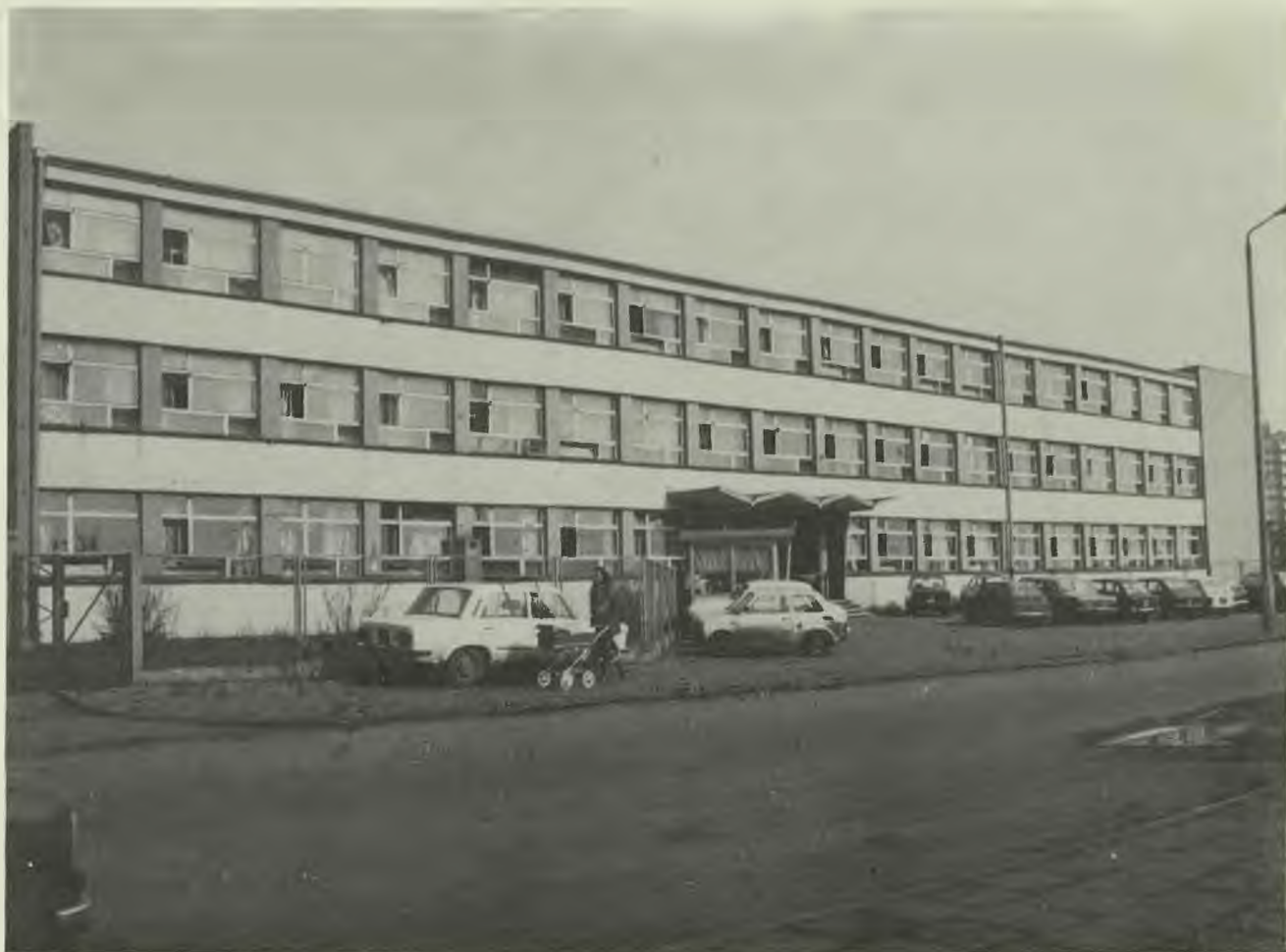
Obiekt główny Wydziału Farmaceutycznego w Sosnowcu
