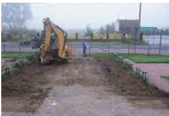
Prace budowlane od strony ulicy Wolności
