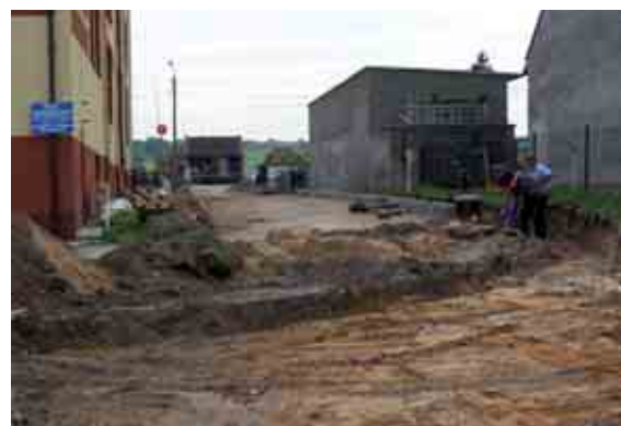
Układanie nowych krawężników
