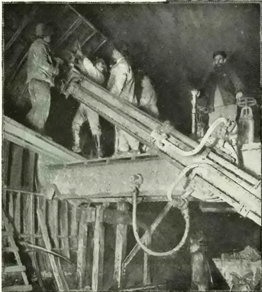
3. Le bras s'allonge et vient plaquer le voussoir à sa place définitive.
