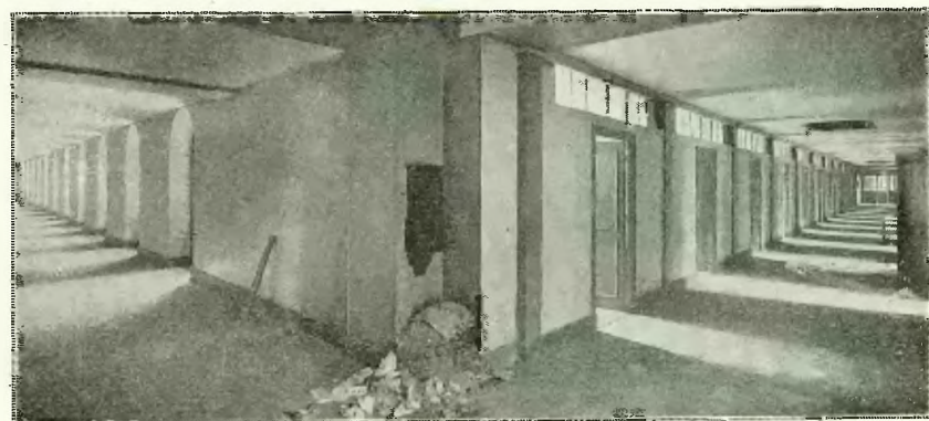
SAINT-SULPICE. — Les couloirs desservant les cellules, futures salles de peinture une fois les cloisons et les plafonds démolis.
