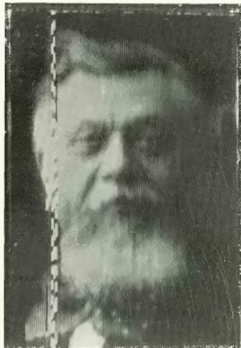
Téléphotographie obtenue sur le circuit Paris-Lyon-Paris, le 1 er février. (La double strie blanche et noire a été causée par une perturbation de 12 secondes sur la ligne.)
