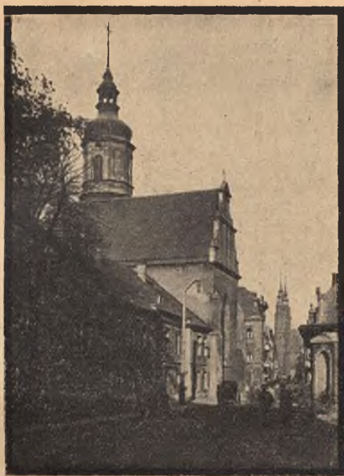
Ev. Kirche Ostansicht
