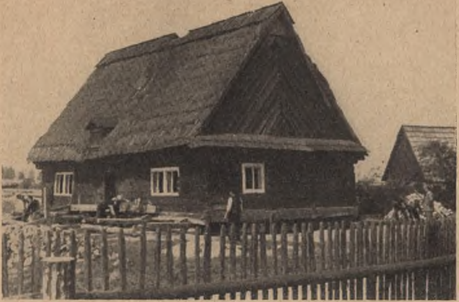
Das Haus ist hochgehoben
