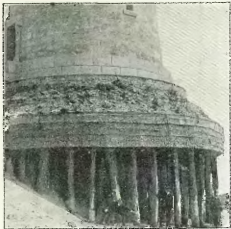
Avant la chute : les pilotis soutenant le phare.
