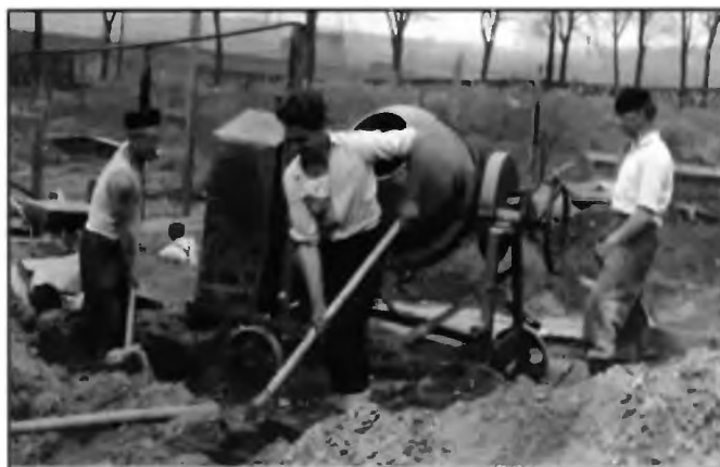
Betonowanie fundamentów nowej szkoły
