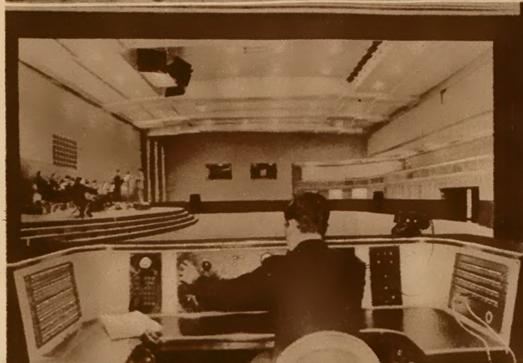
Scena w studio u Rockefellera w Nowym Jorku jest tak nowoczesnie urządzona, że mechanicznie za przekręceniem gałki, jak w aparacie radiowym, scenę można rozszerzać lub zmniejszać zależnie od potrzeb programu.
