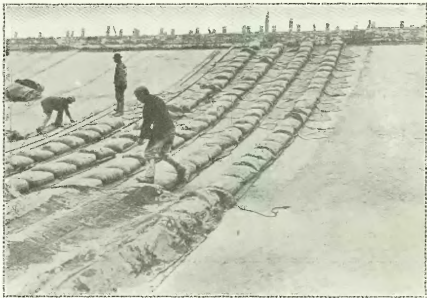
Les sacs disposés pour l'étendage du ciment sur la piste.
