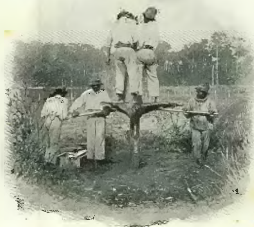
La prospection : le tube, enfoncé jusqu'au bed-rock, donne des échantillons de la terre aurifère avec lesquels on déterminera la richesse moyenne du placer.
