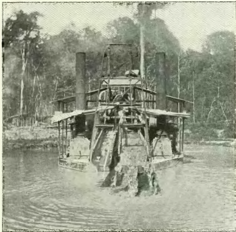
La même drague vue de l'arrière : la boue aurifère, jetée par les godets sur le sluice incliné, passe sur des grilles qui retiennent l'or.
