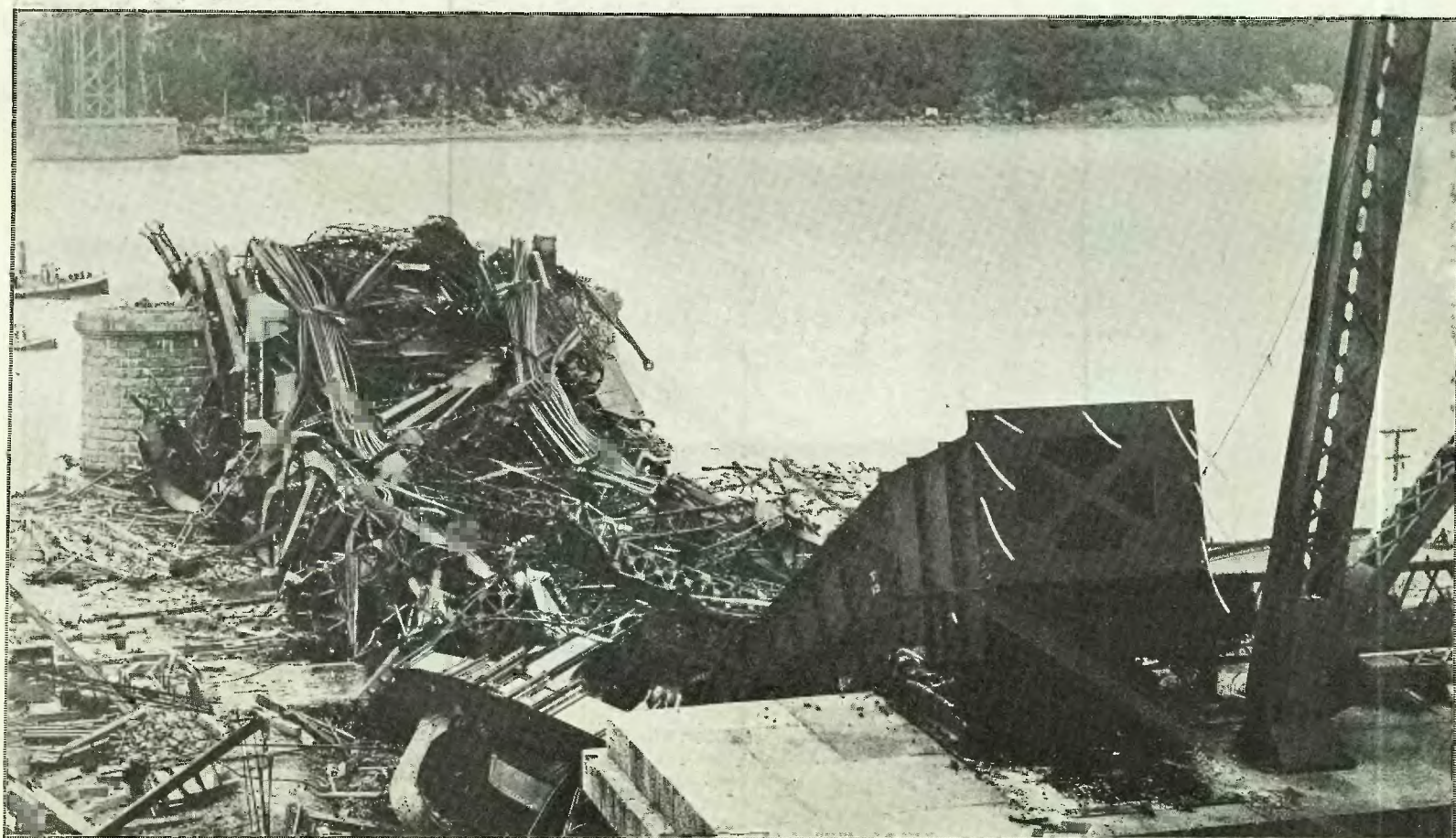
Vue prise de la rive sud, montrant l'arrachement du pylône dominant la culée de rive UNE CATASTROPHE SUR LE SAINT-LAURENT : L'EFFONDREMENT DU PONT DE QUÉBEC. Voir l'article, page 199.
