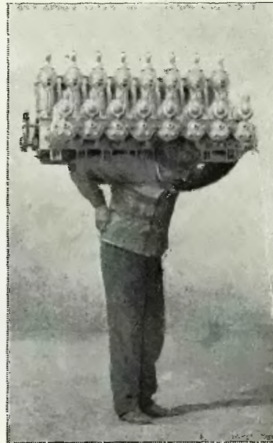
Un moteur de 120 chevaux pesant 120 kilos.
