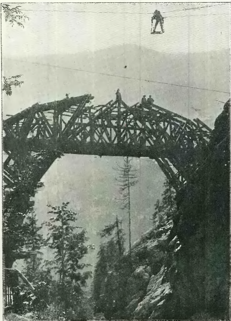
LA CONSTRUCTION DU PONT DU TRIÈGE, ENTRE MARTIGNY ET CHAMONIX. — Le passage d'un ingénieur, à 40 mètres de hauteur, sur un chariot transbordeur pour matériaux. Phot. Ed. Bantty.
