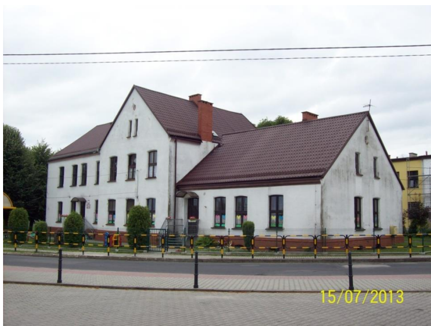
Budynek dawnej szkoły z 1879 roku, stan na 15.07.2013 r. 322
