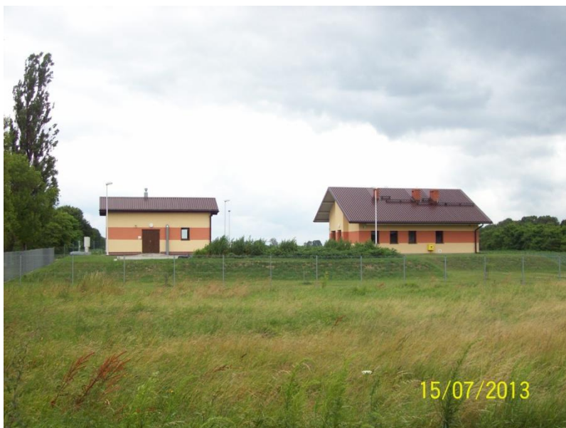
Nowoczesna oczyszczalnia ścieków przy ul. Młyńskiej, 15.07.2013 r. 119
