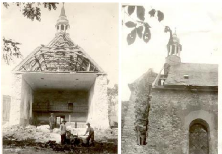
Remont kościoła, 1934 r. 174
