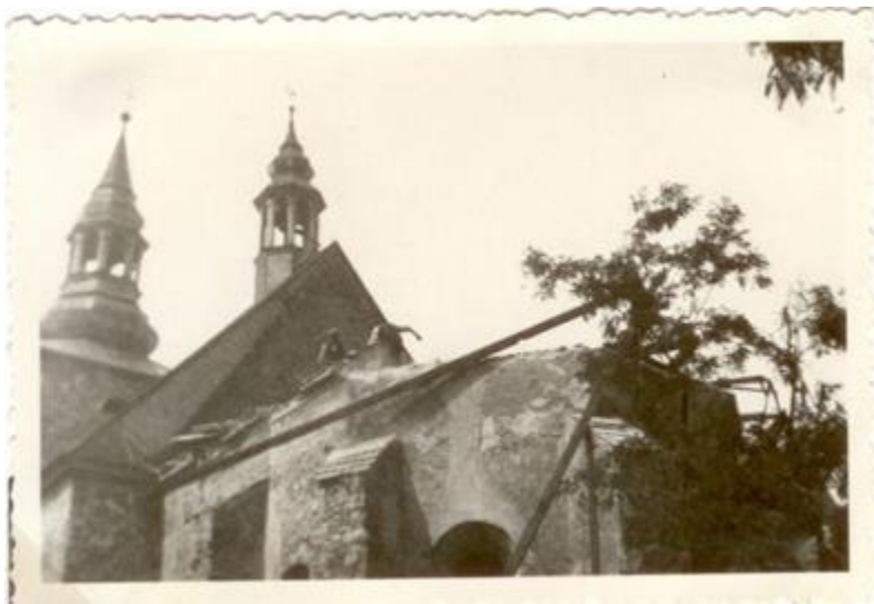
Remont kościoła. Prace przy rozbiórce prezbiterium, 1934 r. 173
