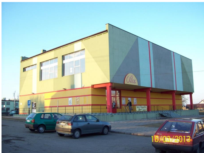
Budynek sklepu „Lux”. Dawniej mieścił się w nim Pawilon Handlowy „Złoty Kłos”, a obecnie sklep „FreshMarket”, 16.03.2013 r. 109
