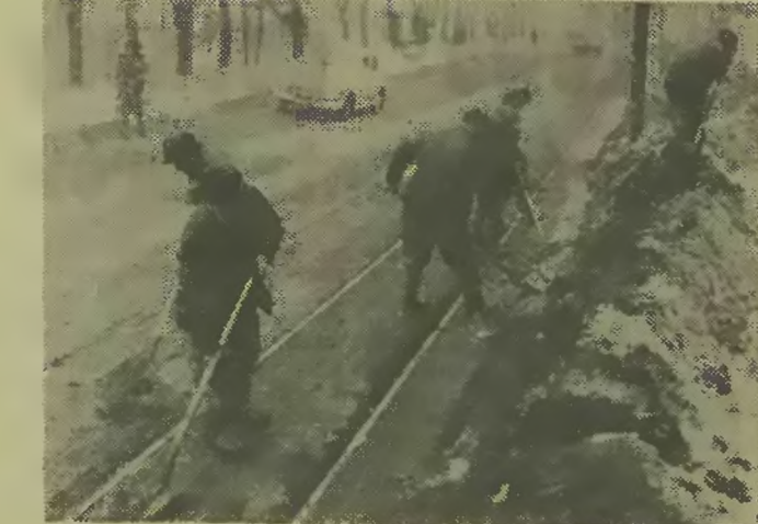
Za chwilę ruszy pierwszy tramwaj — szyny muszą być dokładnie oczyszczone.
