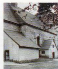
Kościół przed remontem i przebudową w 1934 r.
