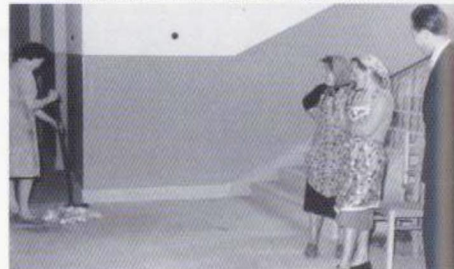
Porządkowanie wnętrza budynku przed otwarciem
