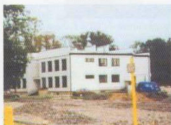
Budynek i teren Gimnazjum w trakcie budowy
