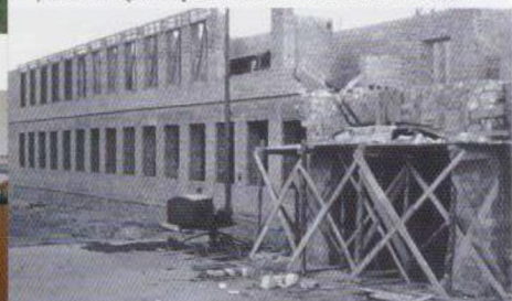
Budowa szkoły 1000 - latki
