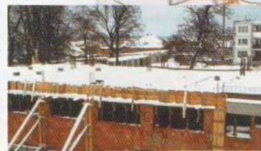
Widok pierwszej kondygnacji, marzec 2004 r.
