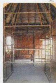
Budowa kaplicy 1999 r.
