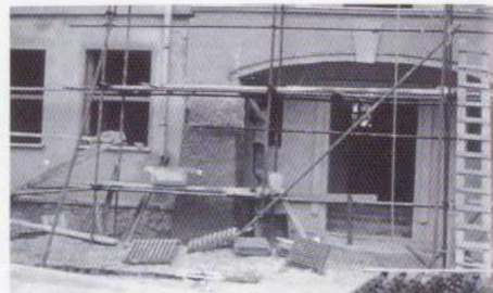
Prace wykończeniowe przy budowie 1000-latki
