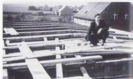
Konstrukcja drewnianego dachu sali gimnastycznej
