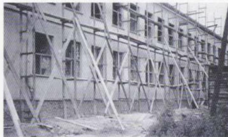
Prace wykończeniowe przy budowie 1000-latki
