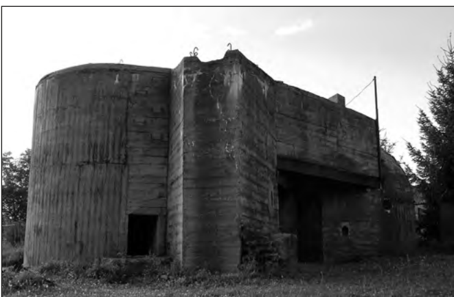
Schron bojowy nr 5 (odcinek fortyfikacyjny Martiany) z roku 1939 w Martianach (niem. Mertenheim)
