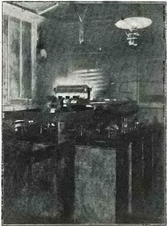
La transmission pendant la nuit : l'étincelle de transmission jaillissant dans l'éclateur.
