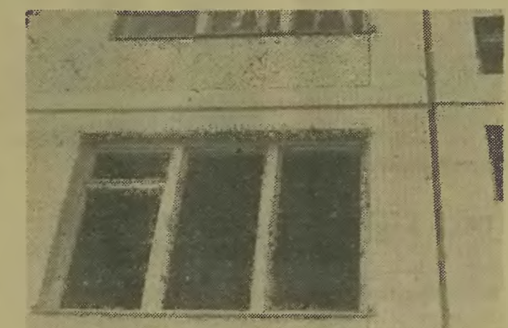
Sciana pokoju z wbudowanym oknem, oszkliwym i malowanym i całkowitą elewacją zewnętrzną — wszystko wykonane w zakładzie prefabrykacji. Element wykonany z żalobetonu. Elewacja wykładana płytkami terrakota.
