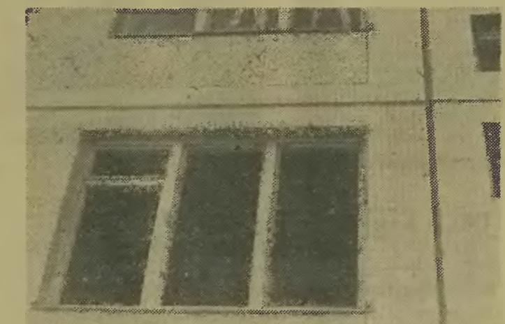
Sciana pokoju z wbudowanym oknem, oszkliwym i malowanym i całkowitą elewacją zewnętrzną — wszystko wykonane w zakładzie prefabrykacji. Element wykonany z żazobetonu. Elewacja wykładana płytkami terrakota.
