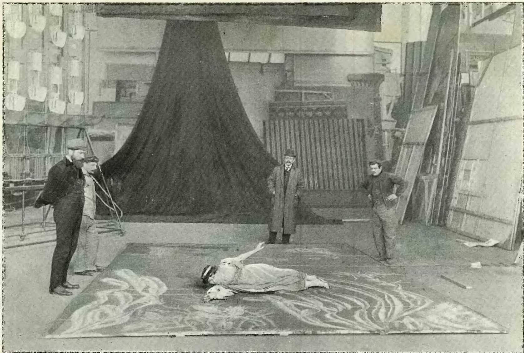
Comment est mimée la scène de LA SIRÈNE : l'artiste se roule sur une toile décorée de plantes marines, tandis que le cinématographe, placé dans les cintres, l'objectif tourné vers la terre, enregistre son jeu sur la bande déjà impressionnée faiblement devant un aquarium.
