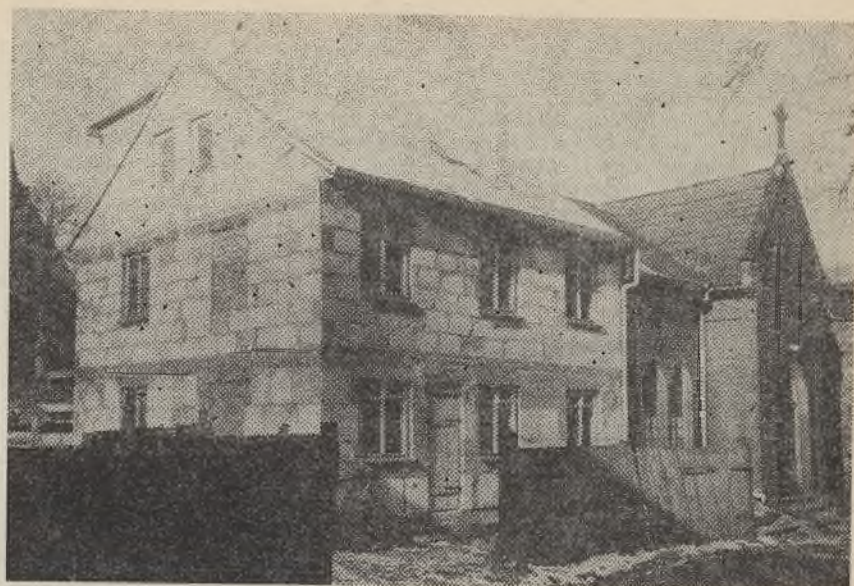
Nowo budowany Dom Zborowy w Lwówku Śląskim
