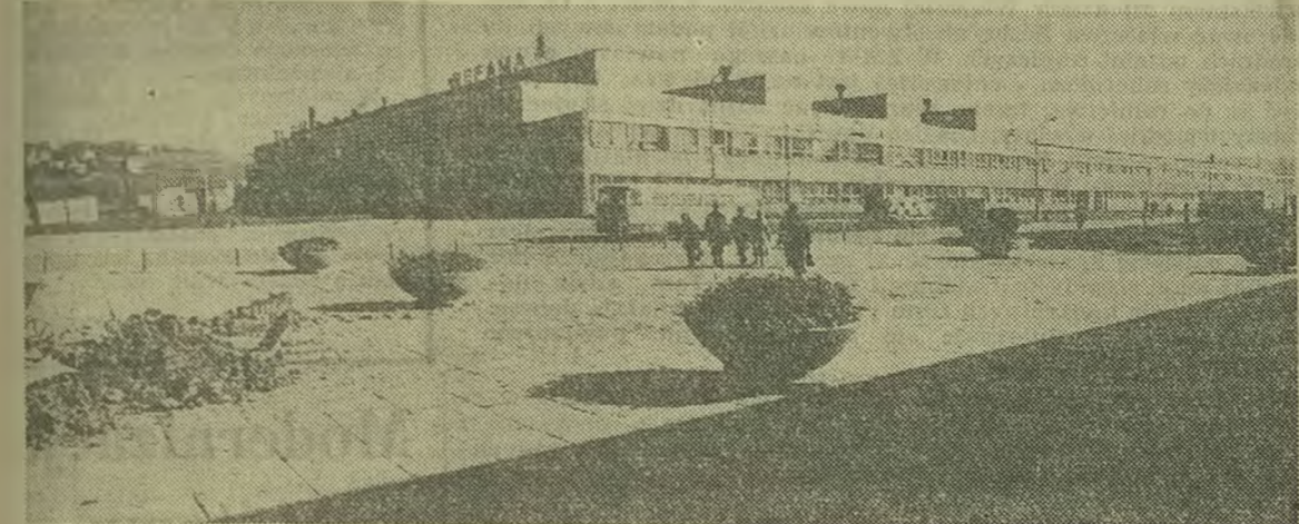
Befama „D”. Przykład nowoczesnego budownictwa przemysłowego.
