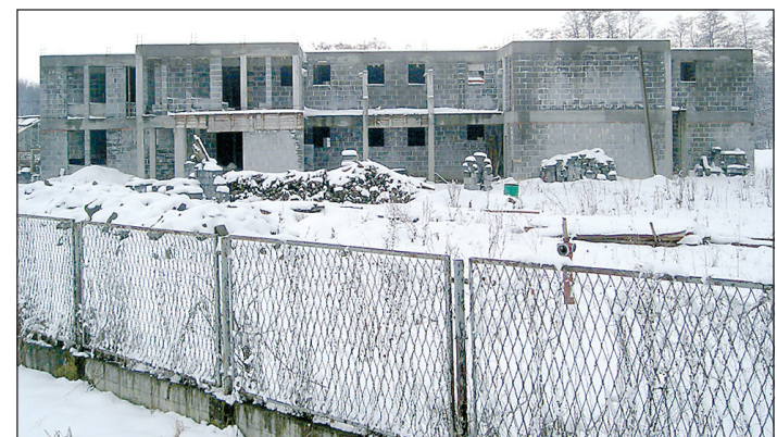
W tym roku władze powiatowe przeznaczą na kontynuację budowy Domu Pomocy Społecznej dwieście tysięcy złotych.
