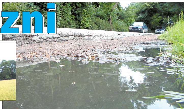
Wzdłuż części ulicy Sobieskiego nie ma chodników. O ruchu pieszych informują tabliczki.
