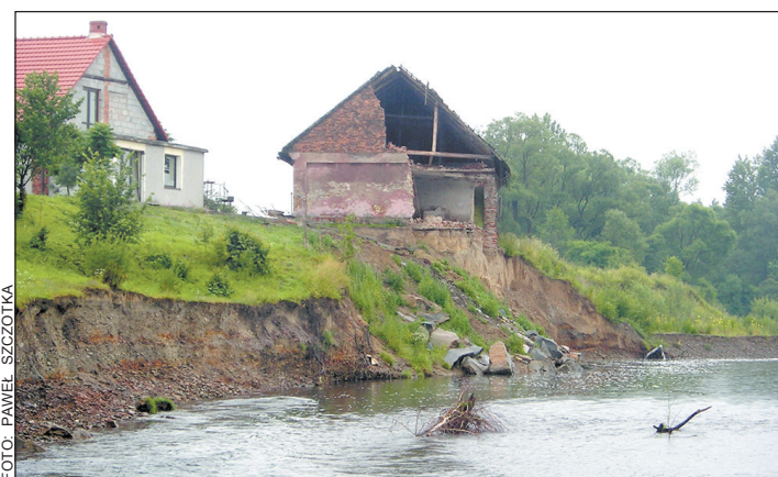
Mieszkańcy już od kilku lat czekają na wykonanie zabezpieczeń w tym miejscu.
