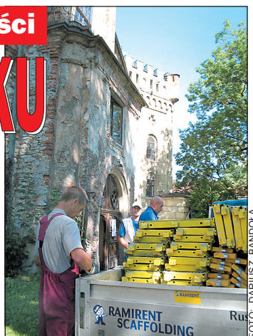
1 września w Starym Zamku rozpoczęto montaż rusztowań.
