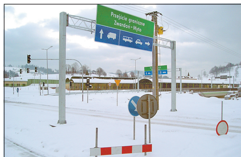
Odcinek ekspresówki w Zwardoni już gotowy, ale jeszcze nieprzejezdny.
