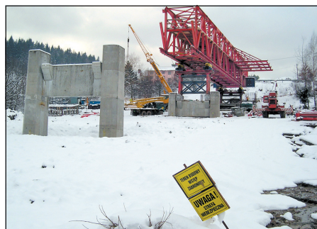
Budowa odcinka ekspresówki na pograniczu Milówki, Kamesznicy i Szarego...
