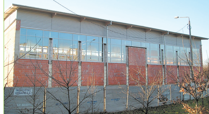
Hala ma być gotowa do połowy listopada.
