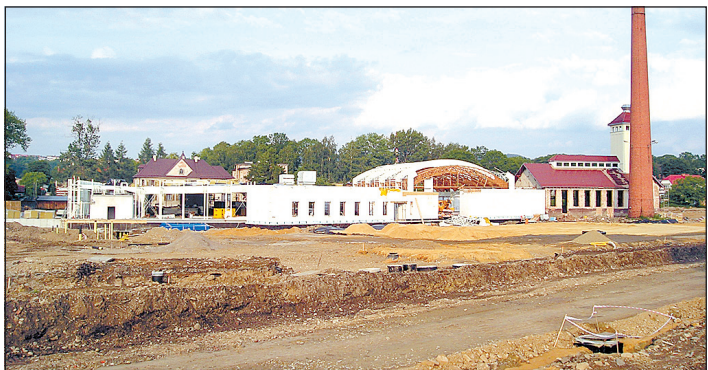
Żywieccy kupcy chcą unieważnienia pozwolenia na budowę Tesco.
