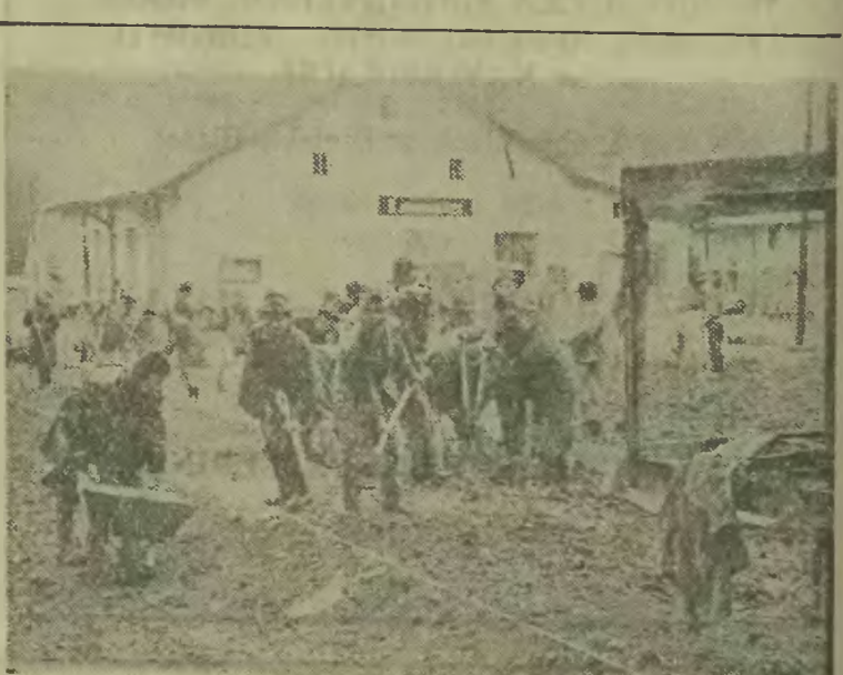
Międzyrzecze — przy skwerze pracują rolnicy Spółdzielni Produkcyjnej.
