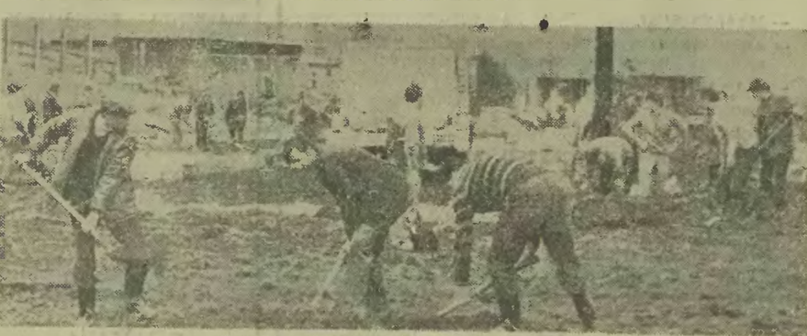
Szczyrk — mieszkańcy przy budowie placu szkolnego.
