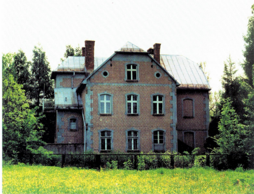
Widok od strony północnej
