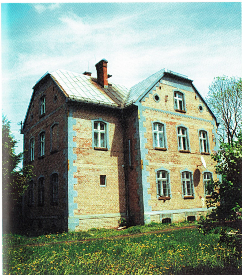
Widok od strony południowej
