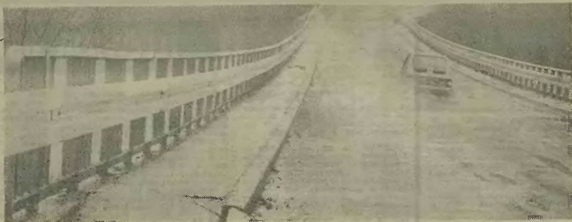
Zdjęcie górne: Bariera energochłonna (wiadukt w Oczkowie — Wilczym Jarze), skuteczność prawie stuprocentowa! Ideal! Zdjęcie dolne: Bariera betonowa (droga Straconka — Miedzybrodzie). Skuteczność problematyczna. Realizm!
