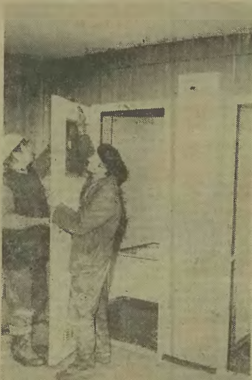
Montaż łazienkowej „kasety” w mieszkaniu jest sprawą prostą i niekłopotliwą...
