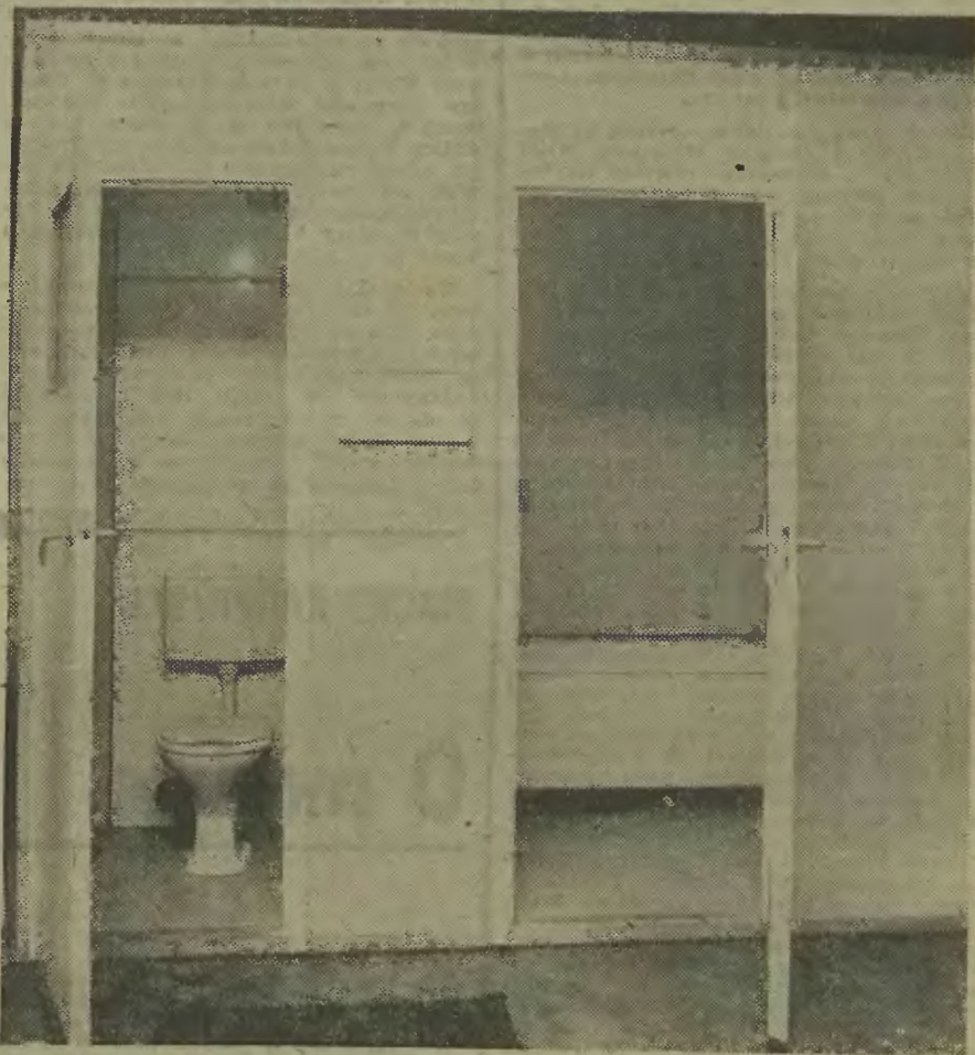
Kompletne łazienki produkowane są na zapleczu w fabryce. Oto jedna z nich.
