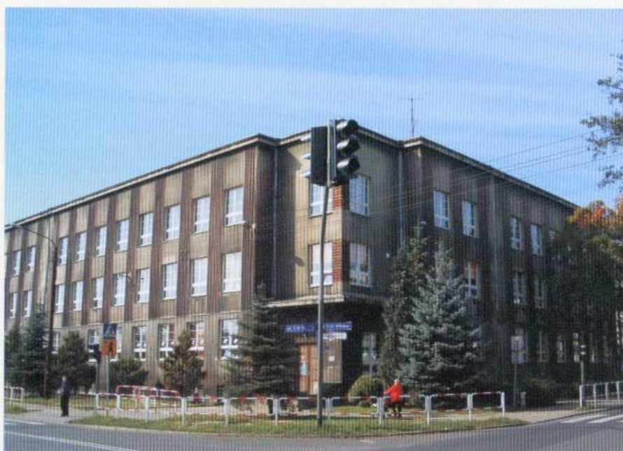
MSP nr 2 przy ul. Wilsona Municipal Primary School no. 2 at Wilsona Street Die Städtische Grundschule Nr. 2 in der Wilsona-Straße
