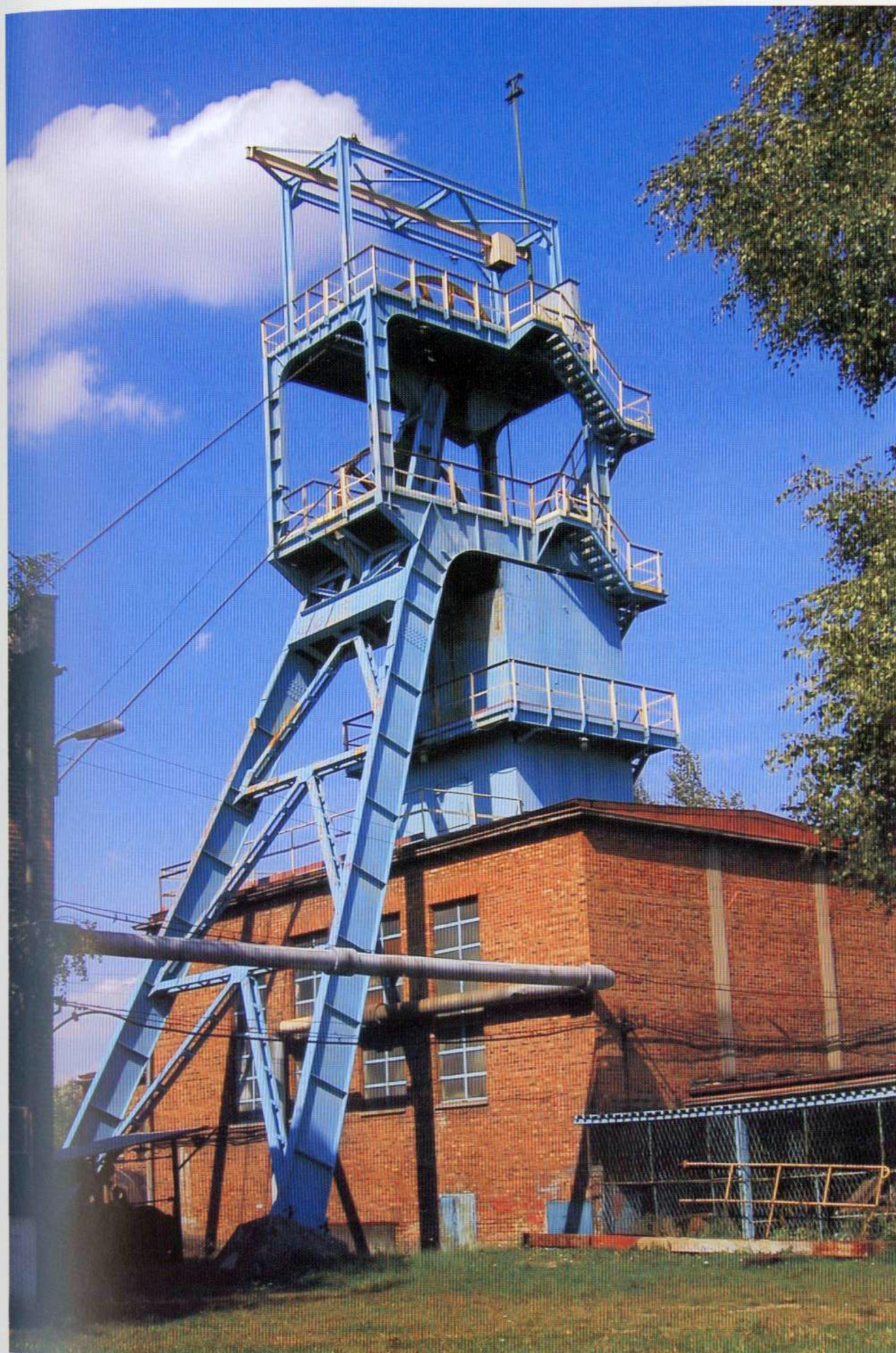
Szyb „Krywald” KWK Knurów. Shaft „Krywald” Coal Mine Knurów. „Krywald”-Schacht des Knurów-Kohlenbergwerks
