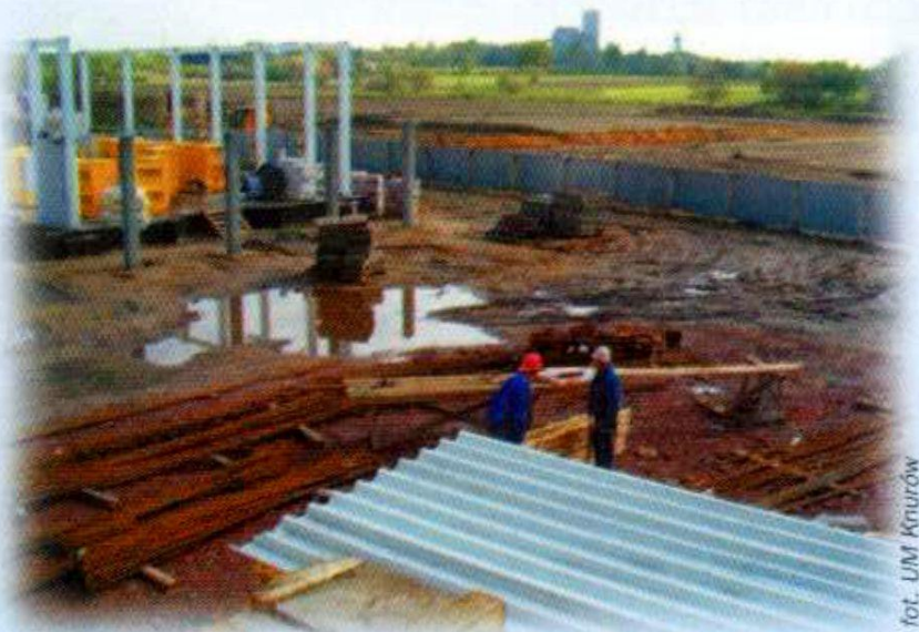
II etap budowy cmentarza przy ul. Rakoniewskiego (I półrocze 2005) The second stage of building cemetery in Rakoniewskiego Street (I half of 2005)
