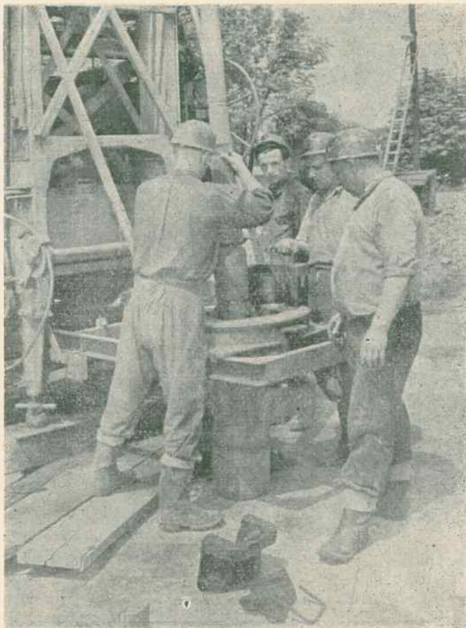
Rys. 21. Składany stół obrotowy przy uderowym aparacie wiertniczym
