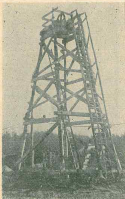
Rys. 48. Prowizoryczna wieża drewniana do głębinia szybów do 50 m
