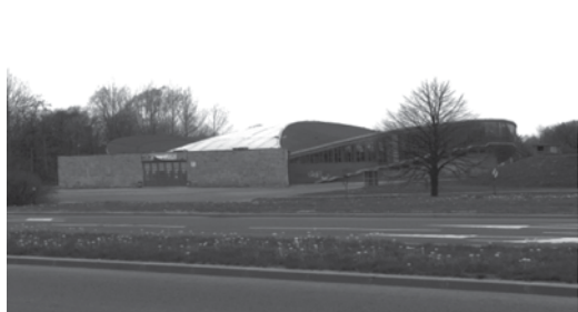
Widok Hali Widowiskowo-Sportowej w roku 2006 – aktualnie przebudowana
