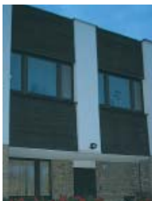
Szalowanie budynku (Katowice)
