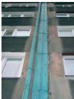
Szczelina dylatacyjna (Chorzów)
