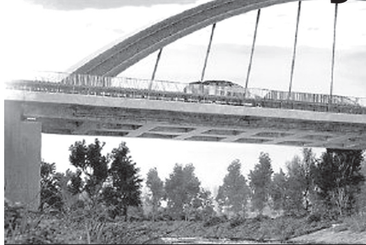
...a tak ma wyglądać po przebudowie.
