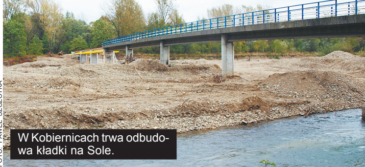
W Kobiernicach trwa odbudowa kładki na Sole.
