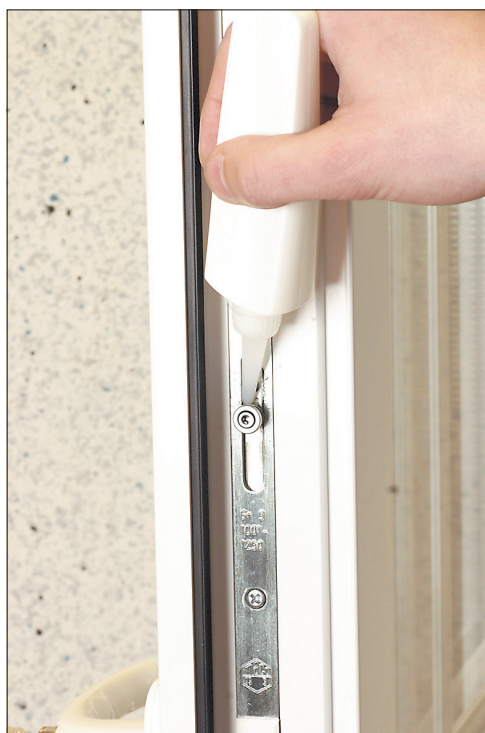
Regulacja i smarowanie okiennych mechanizmów to czynność, którą każdy może przeprowadzić sam.
