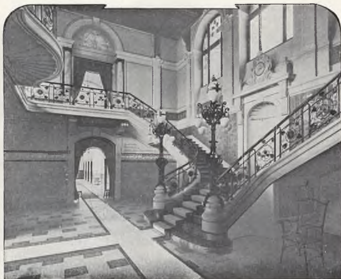
Vestibül der neuen Badeanstalt.
